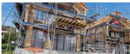
Neubau Birmensdorferstrasse, Zürich
